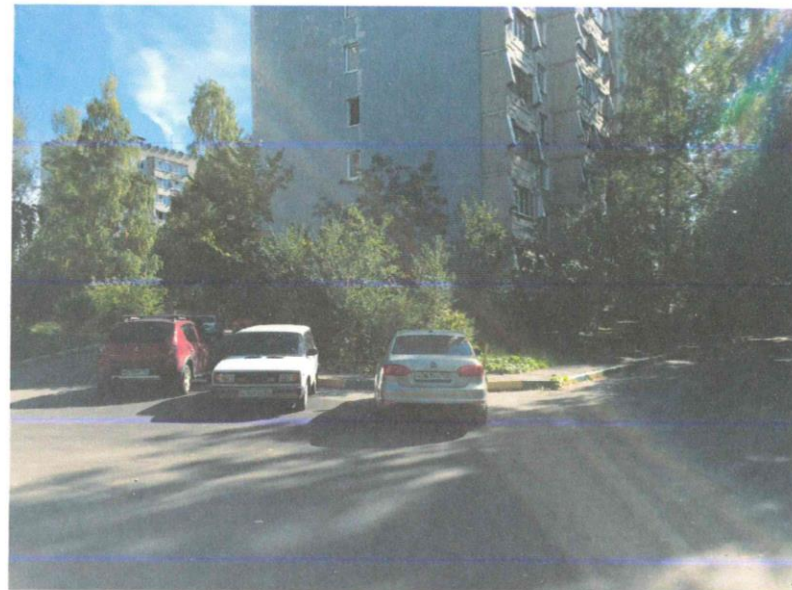
Фото №11. Место парковки автомобилей жильцов многоквартирного дома
