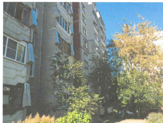
Фото №6. Общий вид на многоквартирный дом
