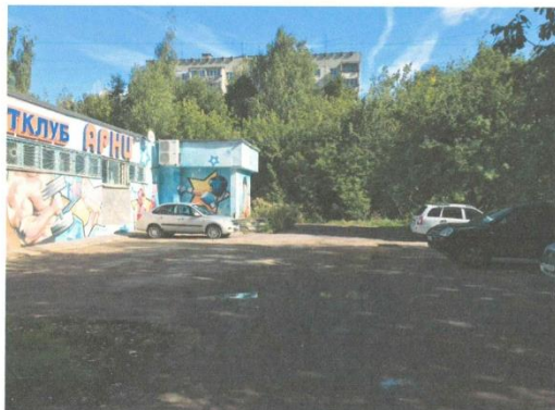
Фото №2. Общий вид помещения с кадастровым номером 52:18:0060214:169
